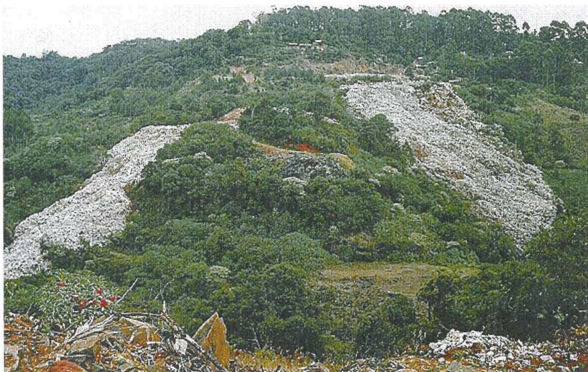
Fig.6.2- Visão geral do antigo lixão. Moradias e catadores de lixo na área.
